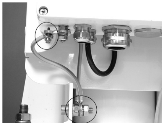
Ilustración 79 Cable de puesta a tierra para TERMBOX
